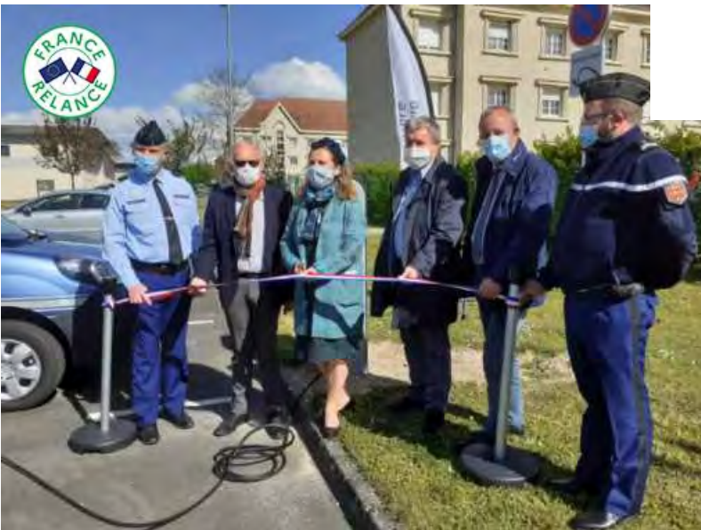
Inauguration de 2 bornes électriques au sein de la caserne de gendarmerie d'Argentan
